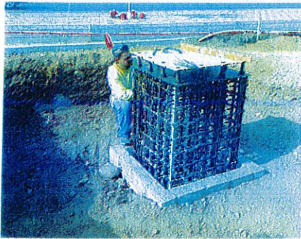
CONSTRUCCION DE DADO DE CIMENTACION PARA LA ESCULTURA DE LA OBRA DE PASEO COMERCIAL
