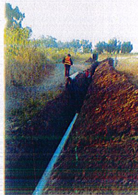
INSTALACION DE LINEA DE CONDUCCION EN LA COLONIA VALLE DE EL GRULLO
