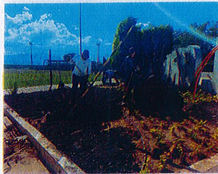
MEJORAMIENTO DE JARDINERAS
