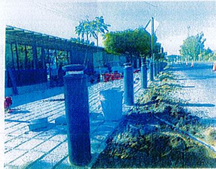
INSTALACION DE BOLARDOS EN LA OBRA DE PASEO COMERCIAL
