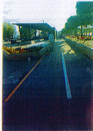
BALIZADO DE LA CICLOVIA EN LA OBRA DE PASEO COMERCIAL
