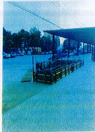
FABRICACION DE JARDINERA EN AREA COMERCIAL
