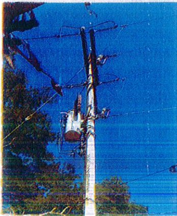
TRABAJOS DE ELECTRIFICACION DEL POZO 10
